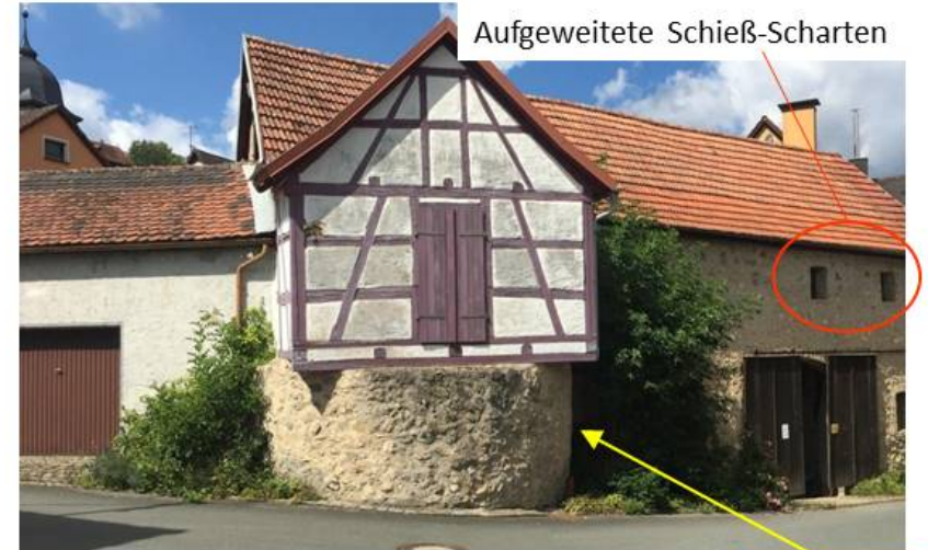
Baubefunde für Schieß-Scharten an der Wehrmauer Betzenstein
